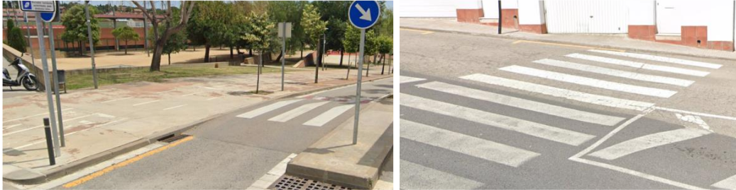
Exemple de passos de vianants, un elevat i l'altre amb el gual sense accessibilitat
